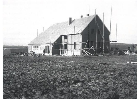
M7 Emslandhof in der ersten Erschließungsphase (Nachlass Kurt Löckmann, NLA OS, Erw A 70; nach Albers 2025, S. 130).
