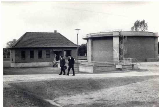
M8 Pumpenhaus Meppen (NLWKN, Betriebsstelle Meppen; nach Schute 2025, Abb. 10).
